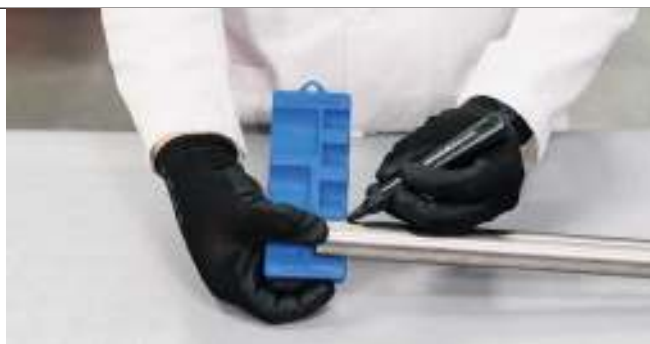
Рис. 28. Маркировка глубины вставки.
